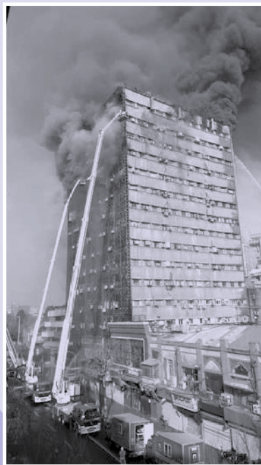
تصویر ۲. ساختمان پلاسکو در آتش
